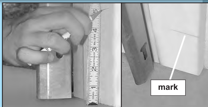
FIG. 4-1 Mark door frame.
